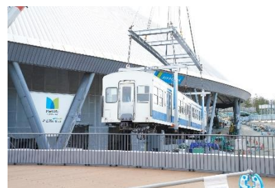
車両を吊り上げる様子
