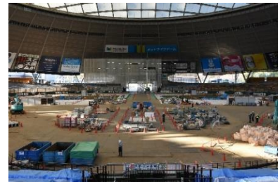
改修工事中の L ビジョン
